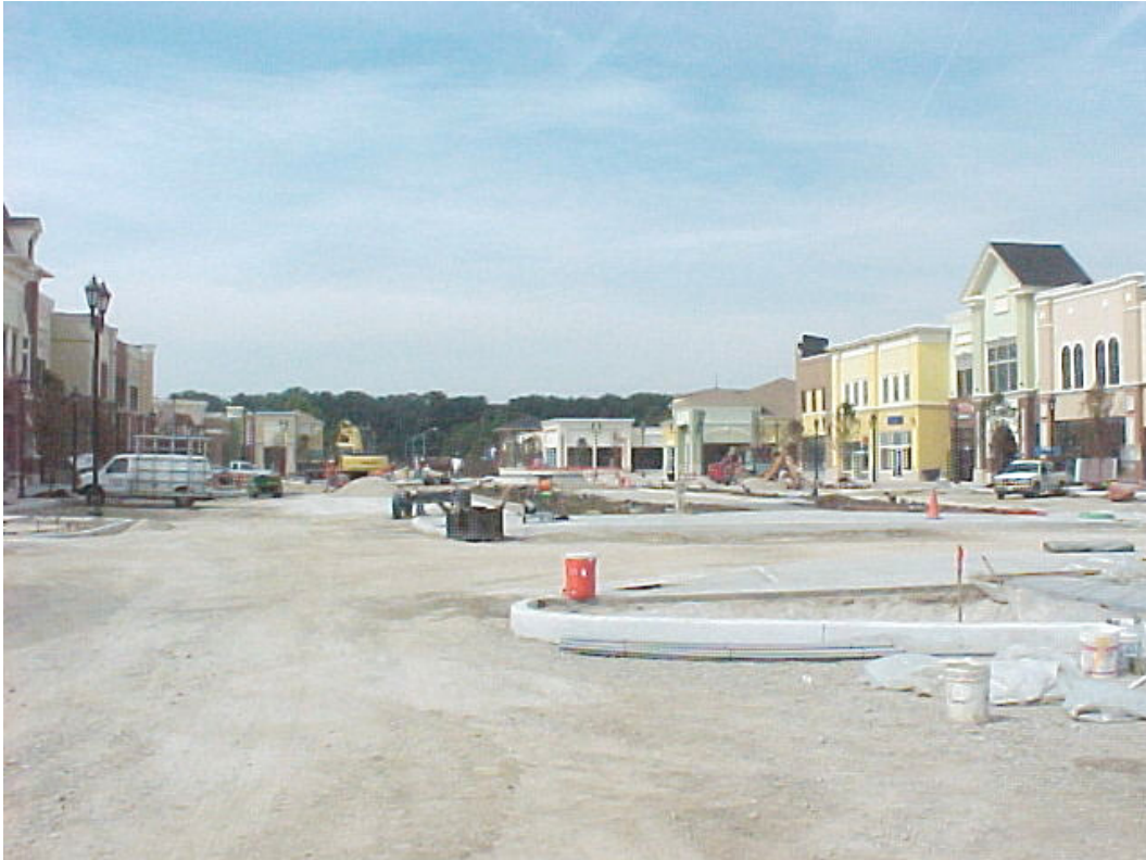
Looking West Levis Commons Blvd
